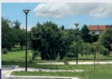
Maintenance et travaux d'éclairage public
